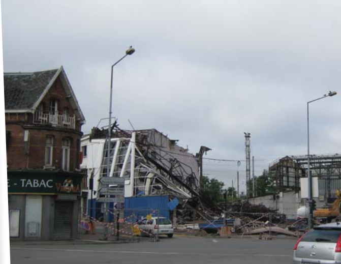
Juin 2012 : travaux EPF
