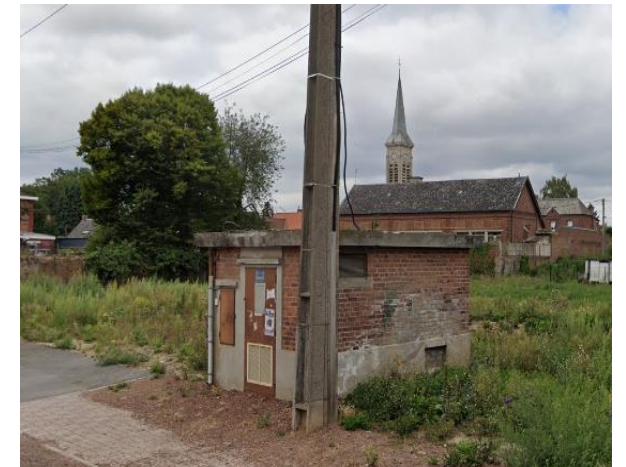
Transformateur sur D 75
